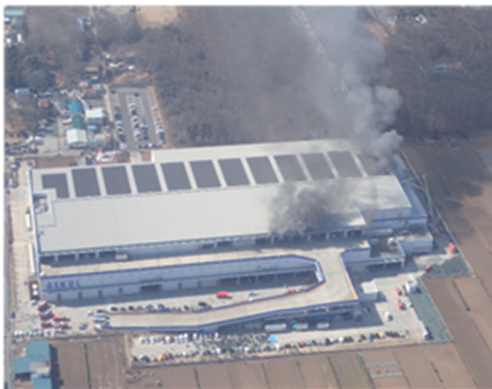
火災時の建物の状況（2月16日12時頃） （埼玉県防災航空隊提供）
